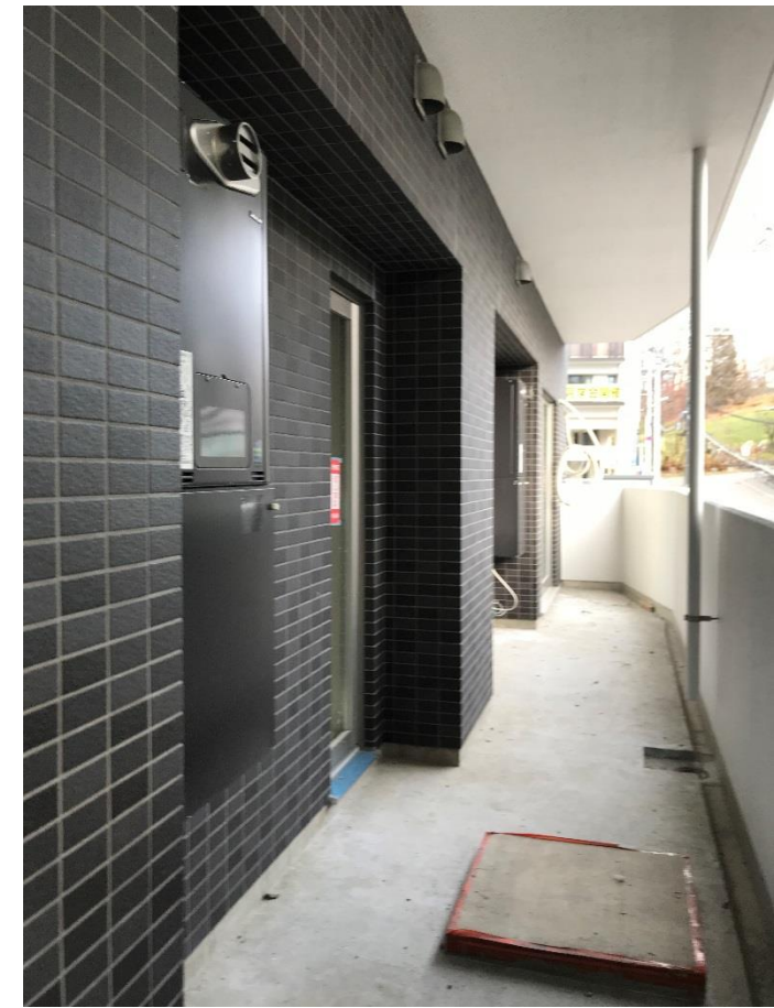
給湯のガスボイラー
