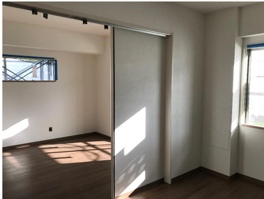
洋室 1 引き戸部分
